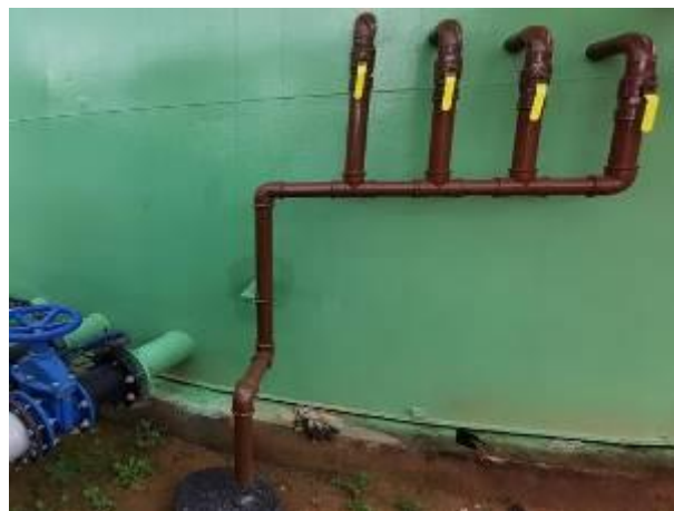
Foto 10 – Tubulação de Coleta de Amostras
