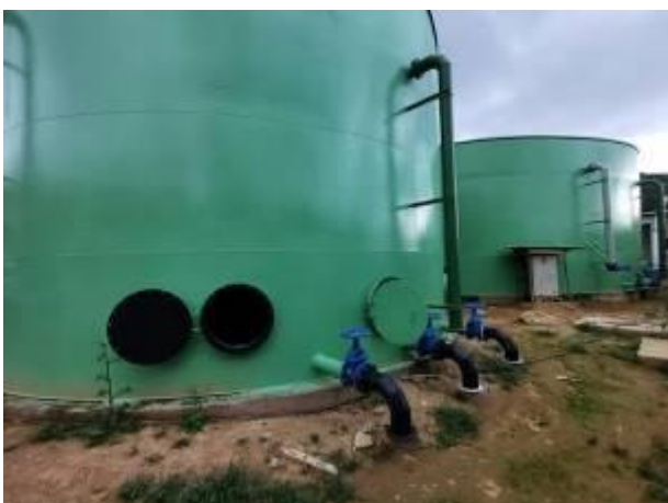
Foto 11 - Saídas Tubulações de Limpeza BF e DS
