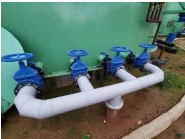
Foto 09 – Tubulação de Descarte de Lodo UASB
