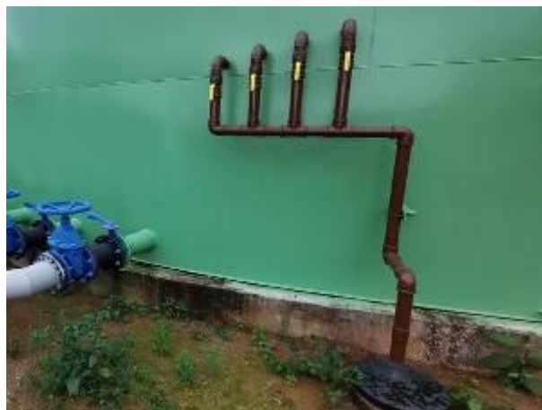
Foto 10 – Tubulação de Coleta de Amostras
