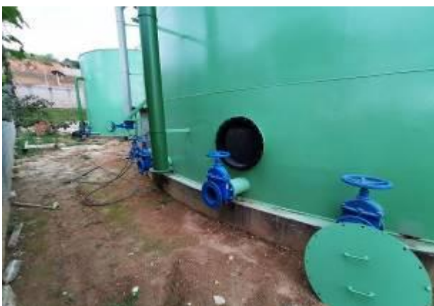
Foto 11 - Saídas Tubulações de Limpeza BF e DS
