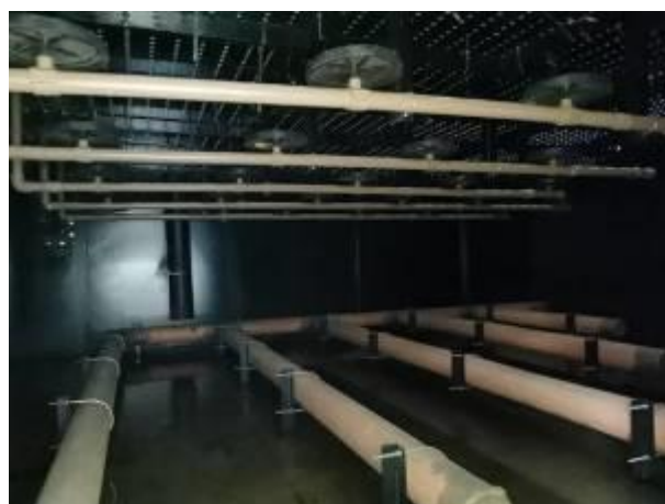
Foto 06 – Biofiltro / Difusores / Distrib. e Limp.
