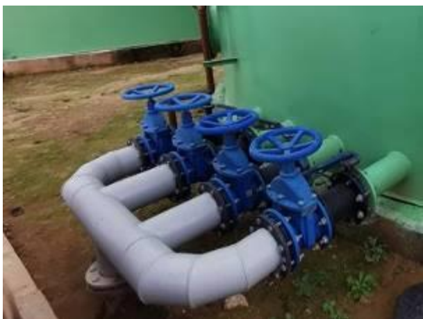
Foto 09 – Tubulação de Descarte de Lodo UASB
